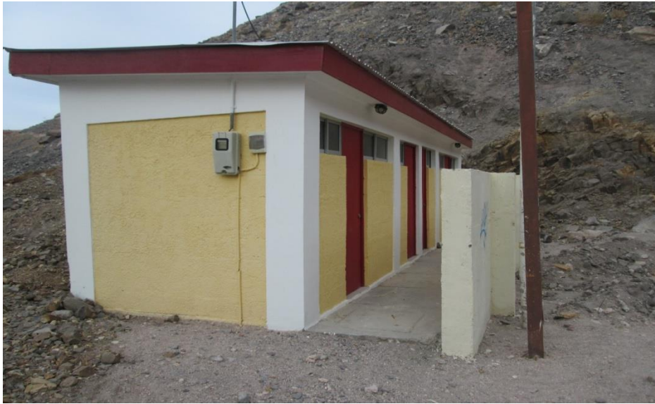
REPARACION CAMARINES Y SS.HH.MULTICANCHA ALTO CAMIÑA, FRIL $ 13.402,627.-
