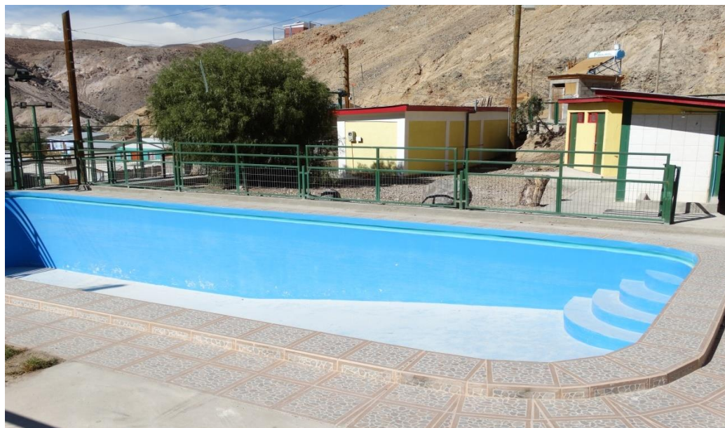
REPARACION COMPLEJO DEPORTIVO DE CHAPIQUILTA, FRIL $66.471.946.-
