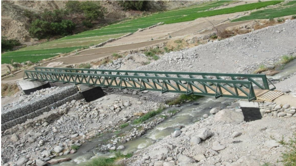
REPOSICION PASARELA PEATONAL DE SAIÑA , FRIL $ 28.206.837.-
