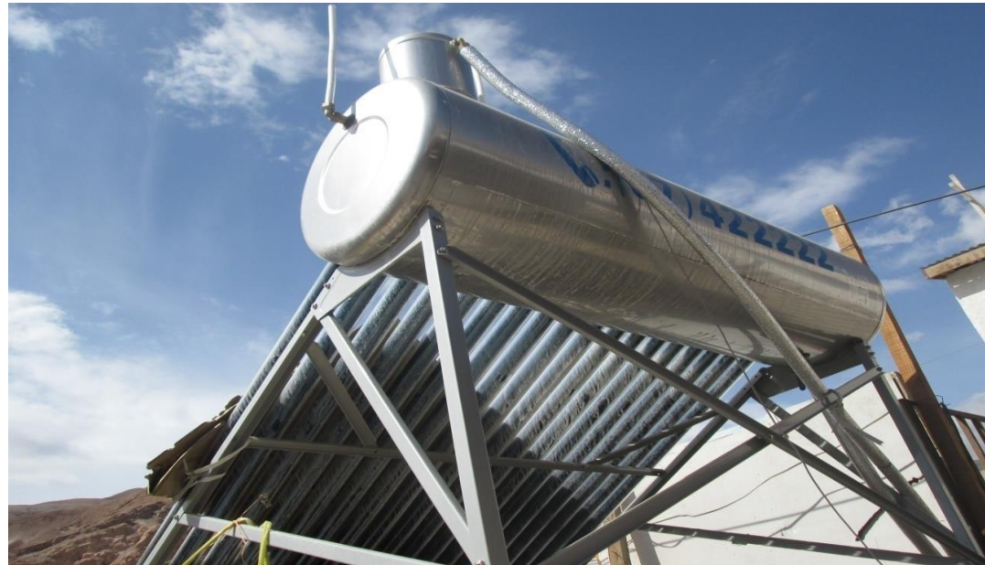
IMPLEMENTACION TERMOSOLARES NAMA, COMUNA DE CAMIÑA, MUNICIPAL $ 8.054.594.-
