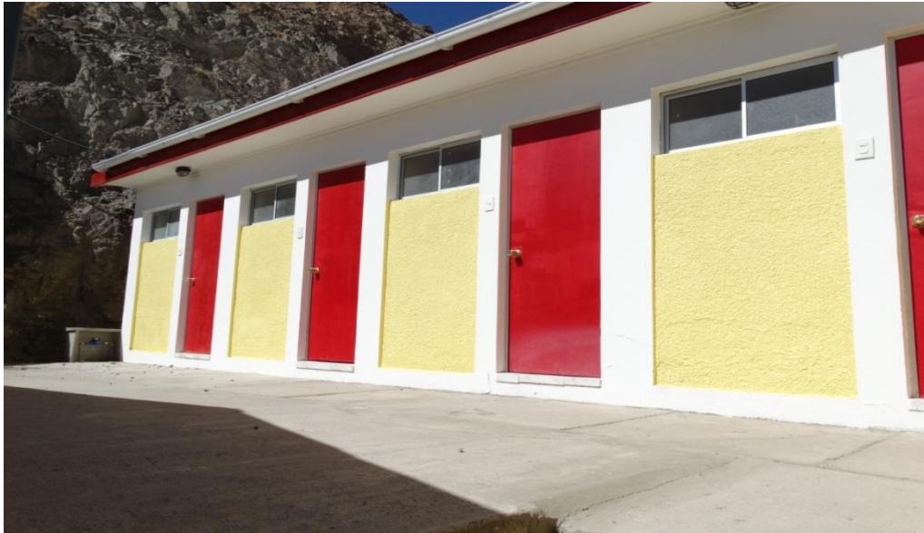
REPARACION SERVICIOS HIGIENICOS PUBLICOS DE YALA-YALA, FRILL $8.350.885.-
