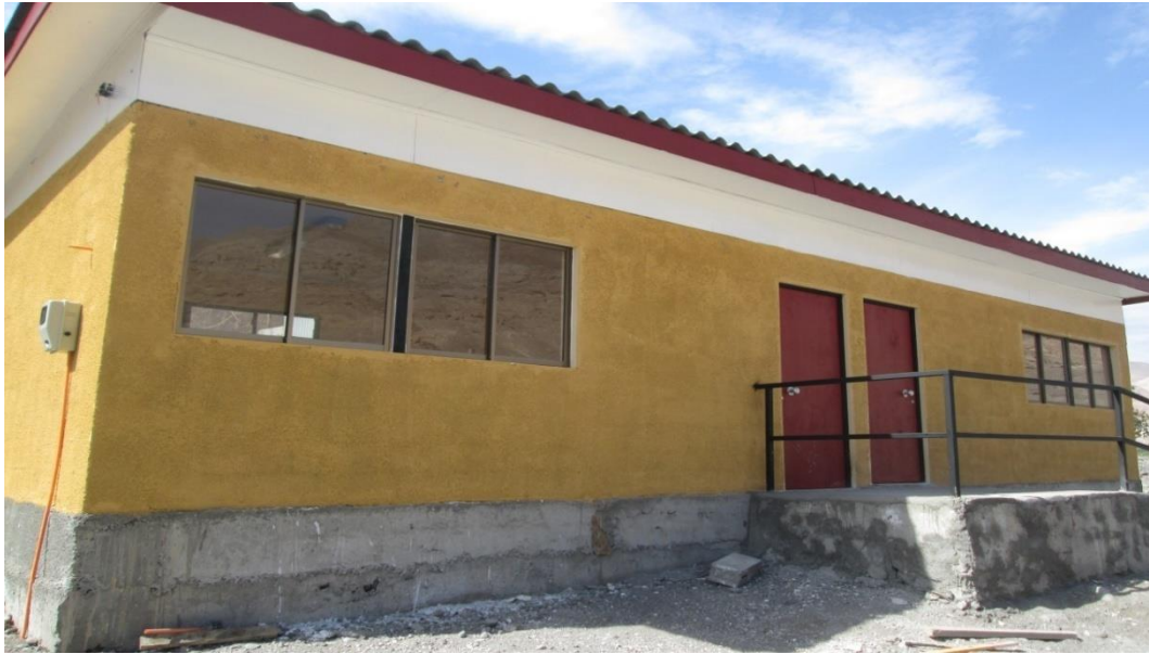
CONSTRUCCION CASA ALBERGUE II ETAPA DE CHILLAYZA, MUNICIPAL $ 11.700.000.-
