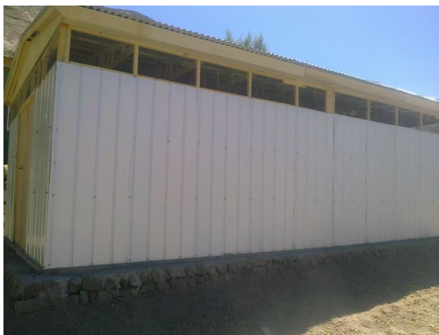
Fotografía N°5: Construcción IFP, Bodega de acopio, usuaria Griselda Ramos, Camiña
