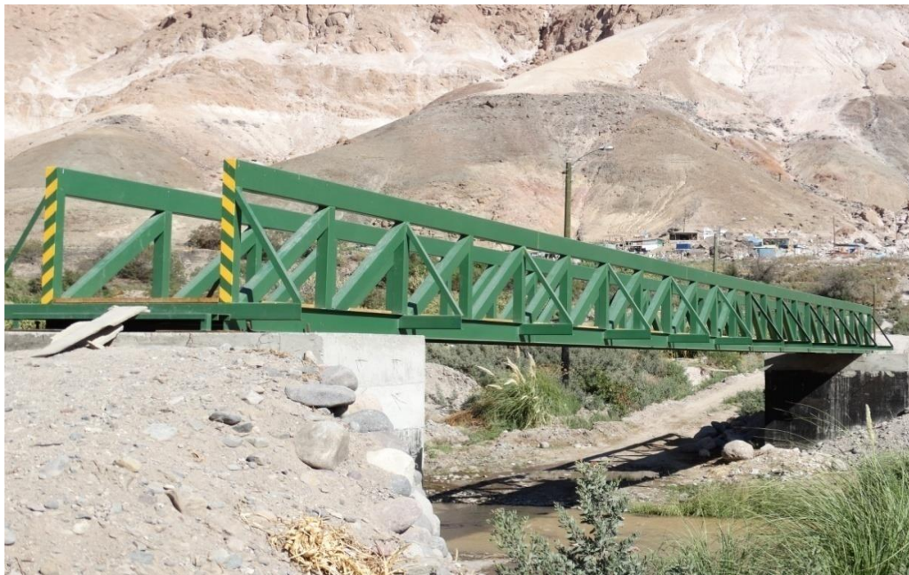
CONSTRUCCION PASARELA PEATONAL DE CAMIÑA, FRIL $28.820.610.-
